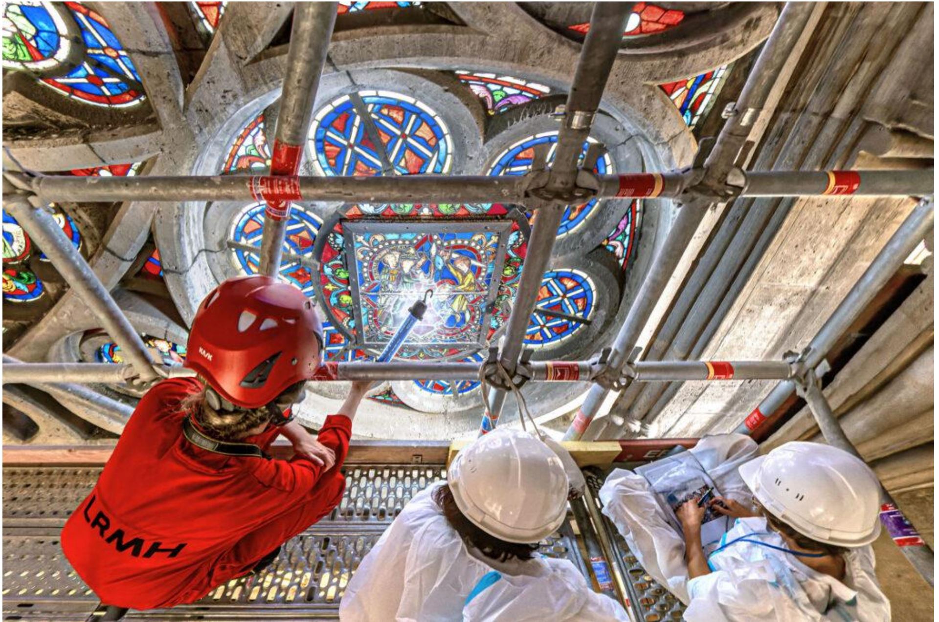
Premiers examens et analyses aux ultraviolets des vitraux de la grande rose du transept nord par une équipe du Laboratoire de recherche des Monuments historiques (LRMH) à l'été 2021. Une chance unique d'accès, grâce à l'échafaudage soutenant le plancher provisoire qui servira à la restauration des voûtes. Auparavant, les historiens d'art ne pouvaient qu'observer ces verrières à la jumelle ! © Stéphane Compoint pour Le Pèlerin
