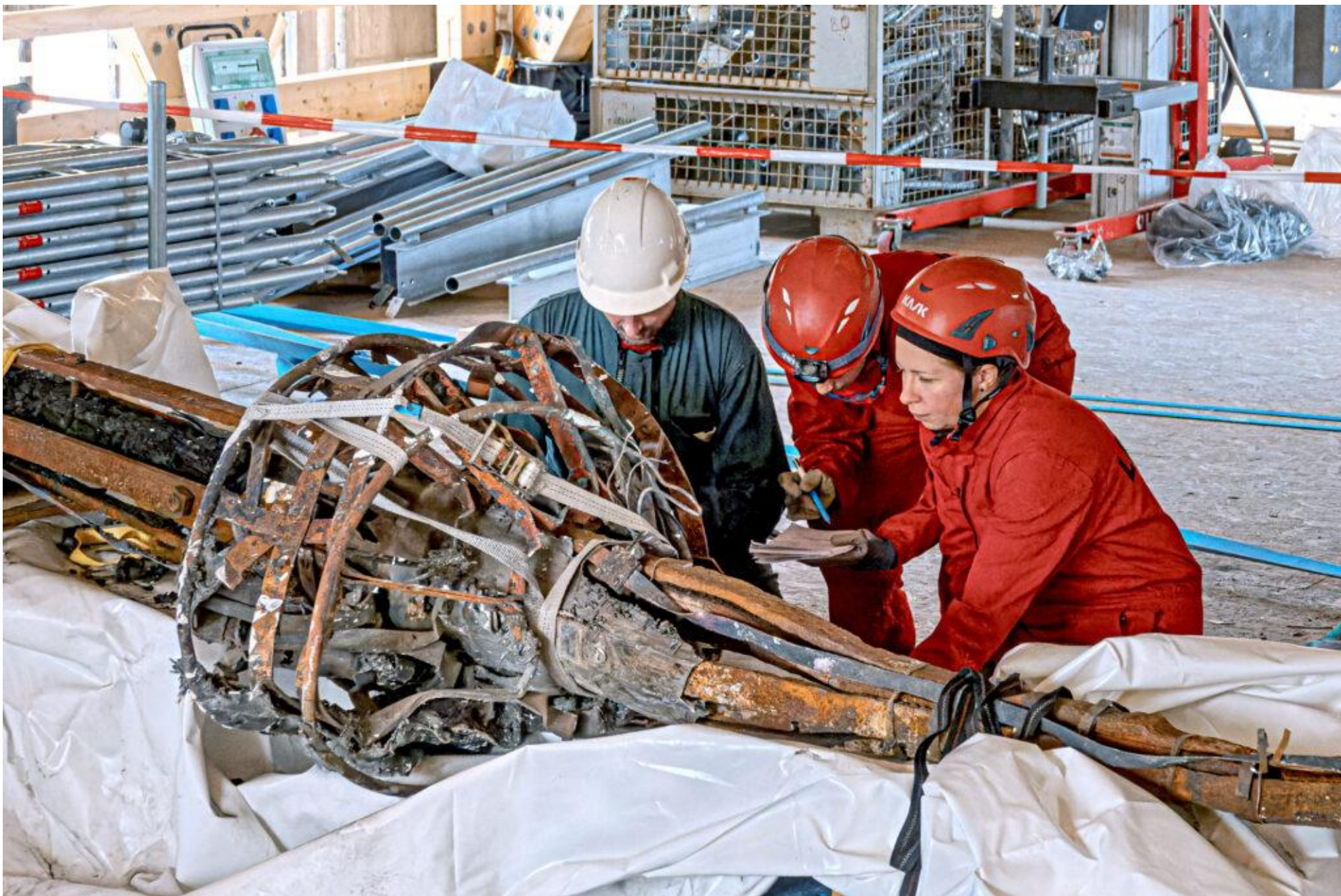
Les premiers échantillons de métal et de bois sont extraits immédiatement par l'équipe spécialisée du laboratoire des Musées de France. Leur étude permettra de mieux connaître cette architecture et d'élaborer de façon plus précise sa réplique à l'identique. © Stéphane Compoint pour Le Pèlerin
