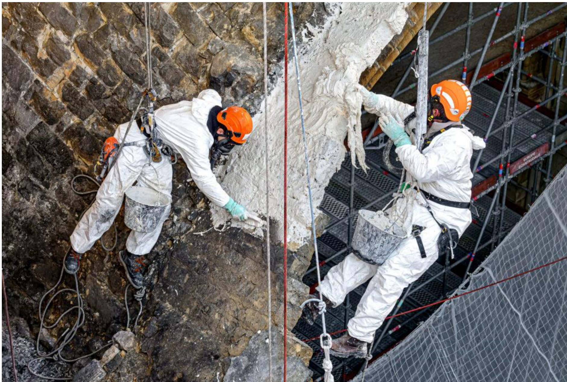
L'été précédent la construction de ces plates-formes, un « cataplasme » en filasse a été posé sur la voûte sud de la croisée du transept par des cordistes de la société Jarnias. Ce travail de consolidation permet d'attendre en sécurité les travaux de restauration des voûtes. Cette vue spectaculaire est prise en plongée depuis la toiture, côté sud-est. © Stéphane Compoint
